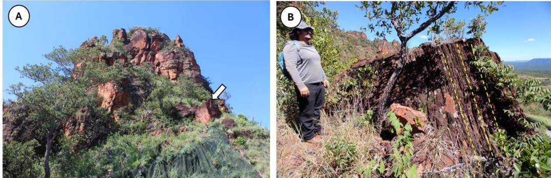
Figura 30: (A) seta indica um bloco de rocha métrico, que caiu em evento anterior de quedas de blocos na região do Portão do Inferno. O Bloco ainda pode ser descalçado e cair novamente atingindo a rodovia; (B) bloco de rocha com mais de 16 metros cúbicos, depositado em depósitos de talus próximo a rodovia, as linhas amarelas indicam as estratificações cruzadas em direção quase vertical, ou seja, em padrão incompatível com a deposição em ambiente desértico.
