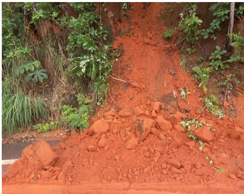
Figura 1: Registro de um dos eventos de quedas de blocos registradas na MT 251.
